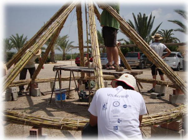
Construcción del sombraje para un observatorio.
