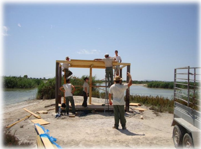
Construcción del observatorio para aves.
